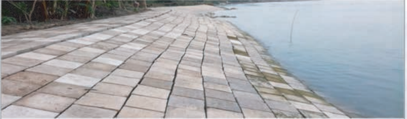
চিত্র ১.৬: জলবায়ু পরিবর্তন ট্রাস্ট ফান্ডের অর্থায়নে নদী ভাঙ্গনরোধে নদীর তীর রক্ষা বাধ নির্মাণ
