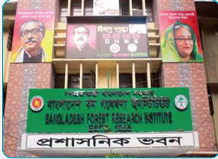
চিত্র ৬.১: বিএফআরআই-এর প্রশাসন ভবনে মুজিব-১০০ ক্ষণ গণনা ডিজিটাল বোর্ড স্থাপন।
