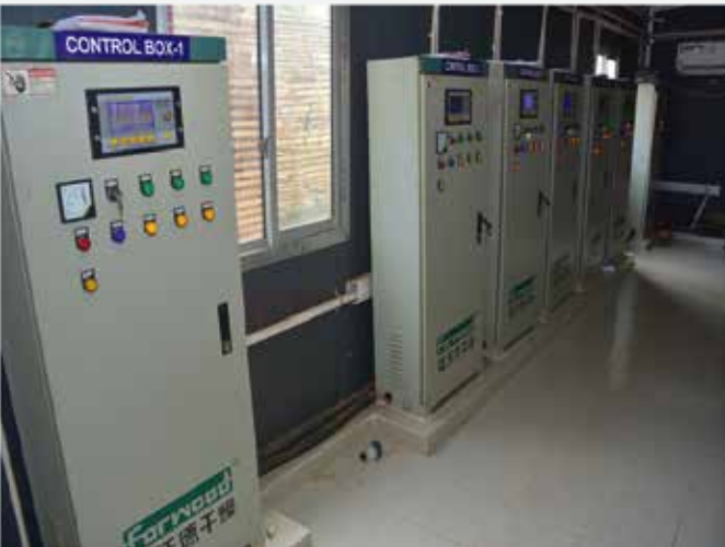
চিত্র ৫.৩: বশিউক, রাবার কাঠ প্রেসার ট্রিটমেন্ট পান্ট, শ্রীমঙ্গল, মৌলভীবাজারে অত্যাধুনিক সিজনিং চেম্বারের কন্ট্রোল রুম।
