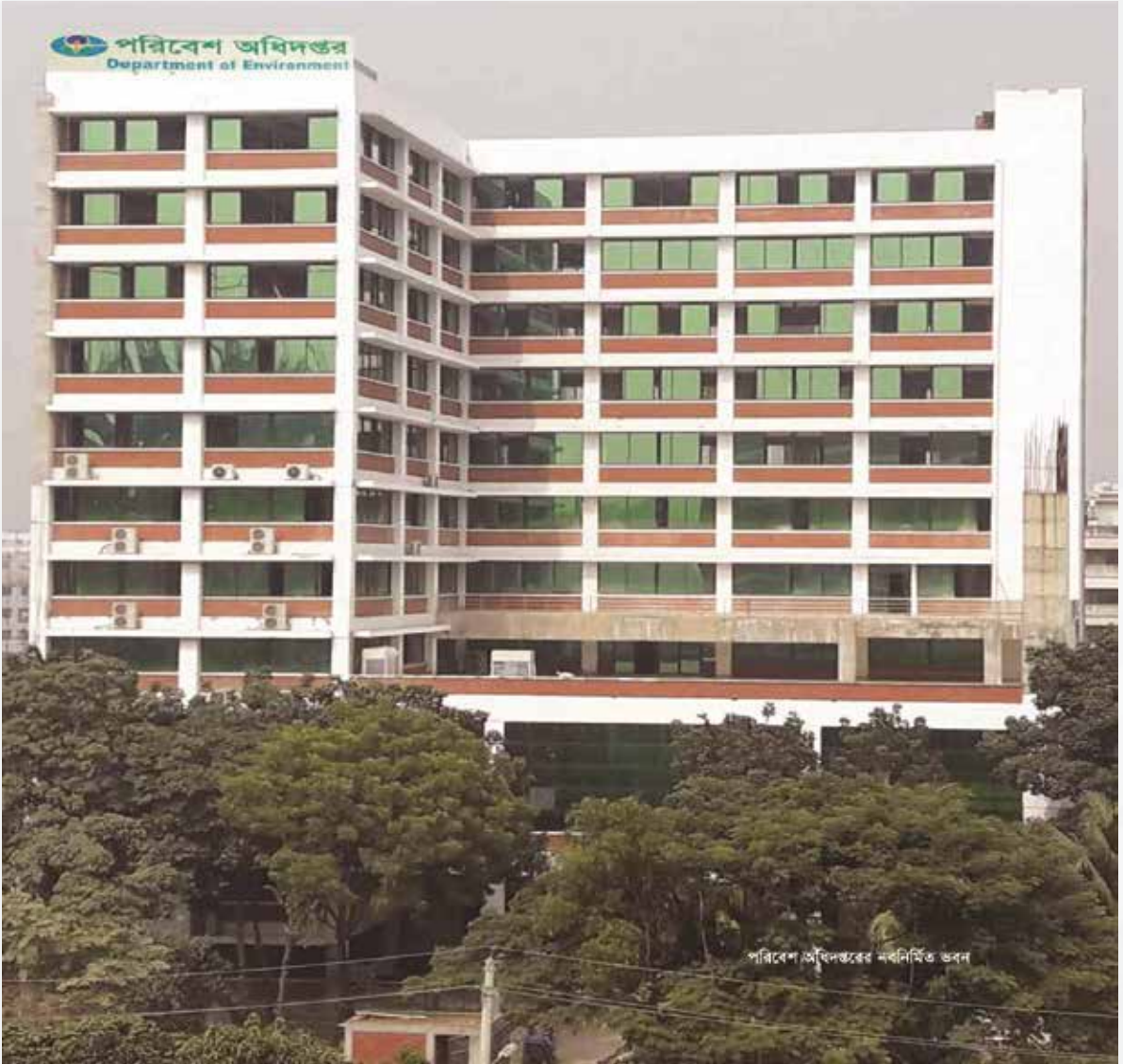
চিত্র ২.১: পরিবেশ অধিদপ্তরের নবনির্মিত ভবন।
