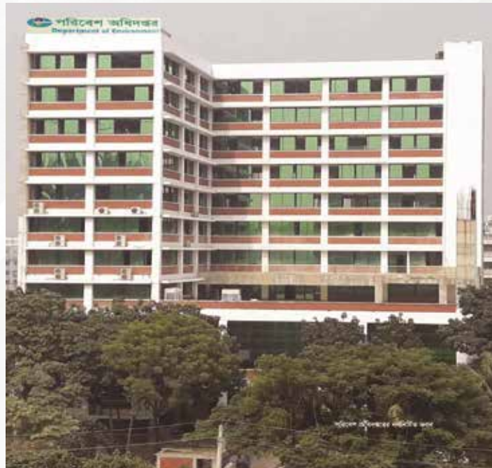
পরিবেশ অধিদপ্তরের নবনির্মিত ভবন
